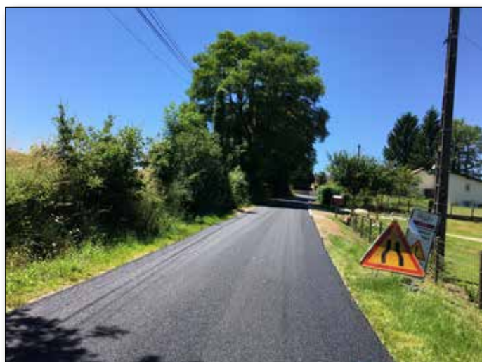
Travaux de voirie par Tulle Agglo. Montant : 23 900,00 € Juin 2016
