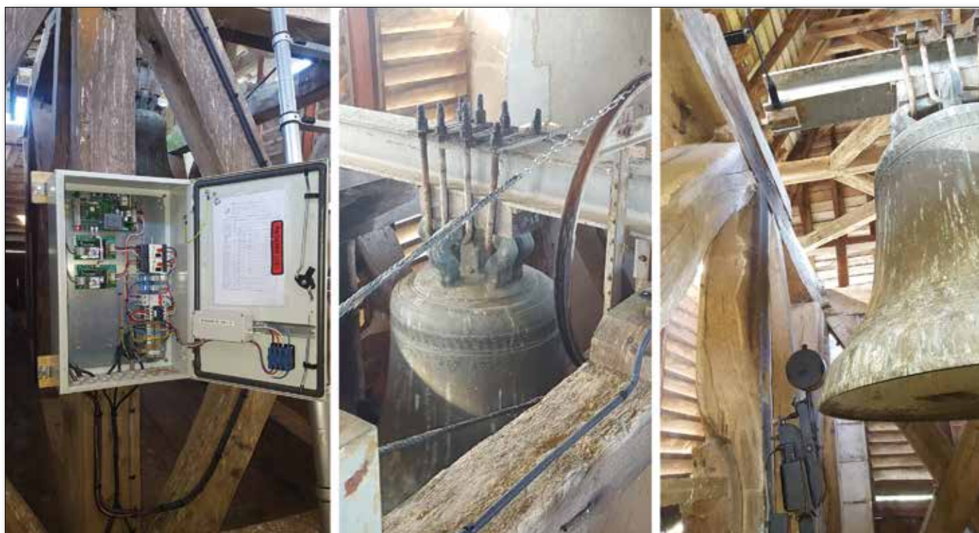
Mise aux normes du système d'électrification des cloches et réfection des moteurs. Montant : 4 872,00 € - Septembre 2016
