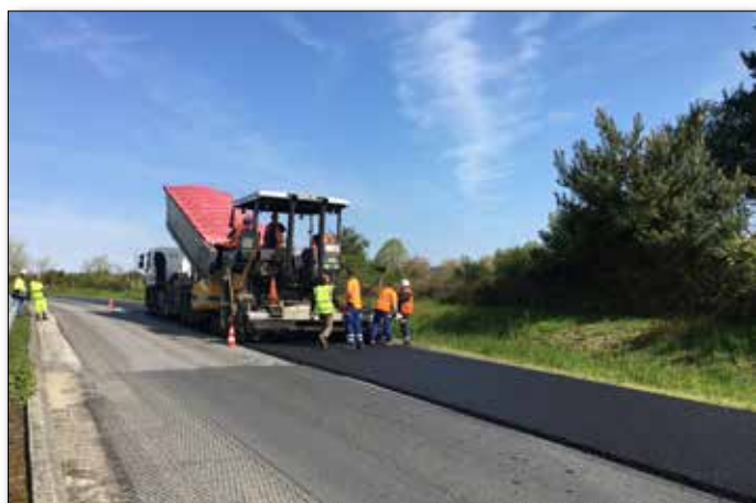
Travaux de voirie «D9» réalisés par Eurovia et financés par le Conseil Départemental Mai 2016
