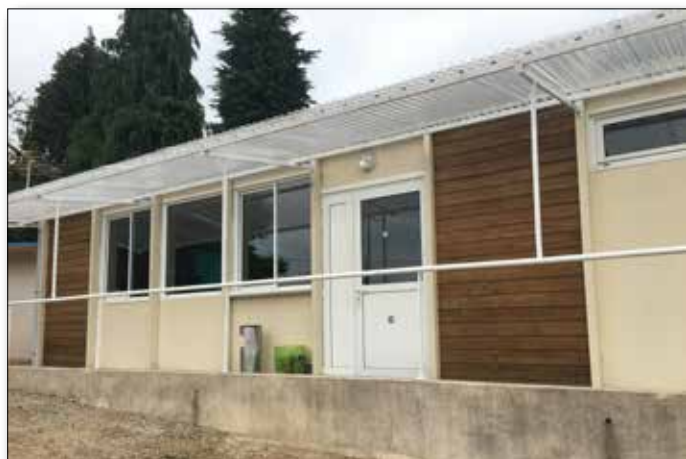
Pose d'un auvent réalisé par le Président du foot «Dany PONS» Club House Stade de Chadebec
